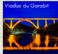
Viaduc du Garabit
