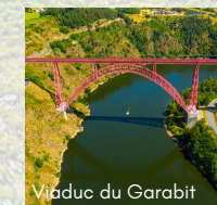
Viaduc du Garabit
